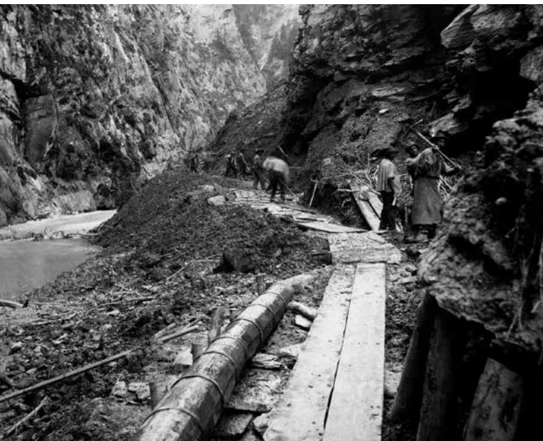
1840: Verlegung der Thermal Wasserleitung The thermal water pipeline is laid
